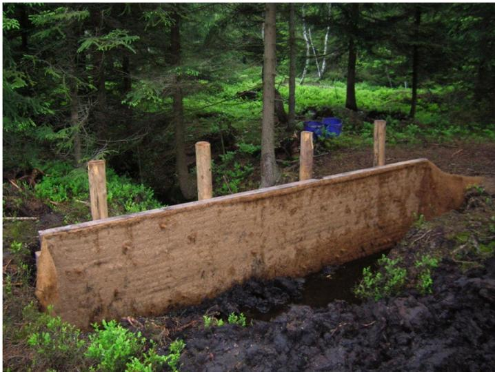
Abbildung 7 - Bohlendamm mit Geo-Textil aus Kokosfasern vor dem Überfüllen
