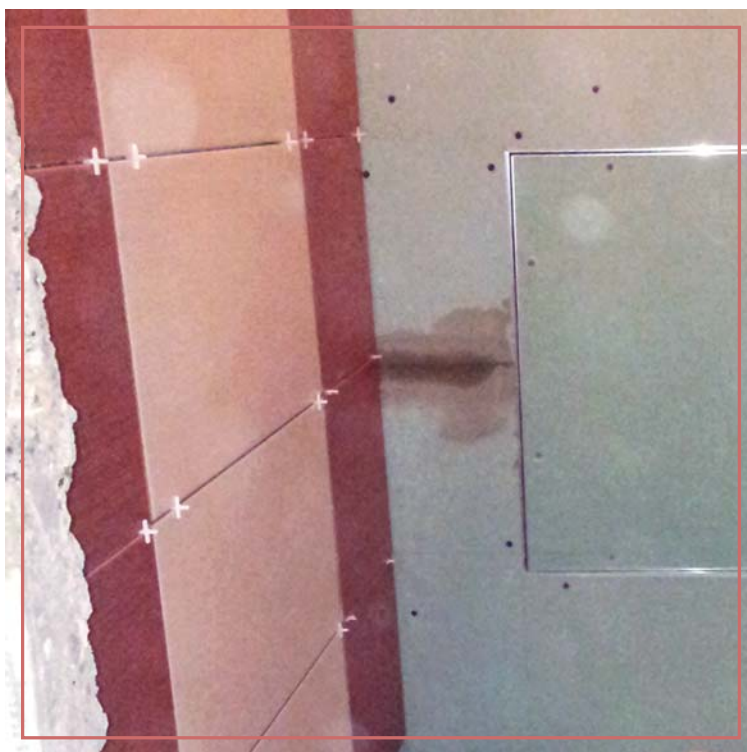
Příprava obkladů na spárování – ukázka použití vodících křížků
