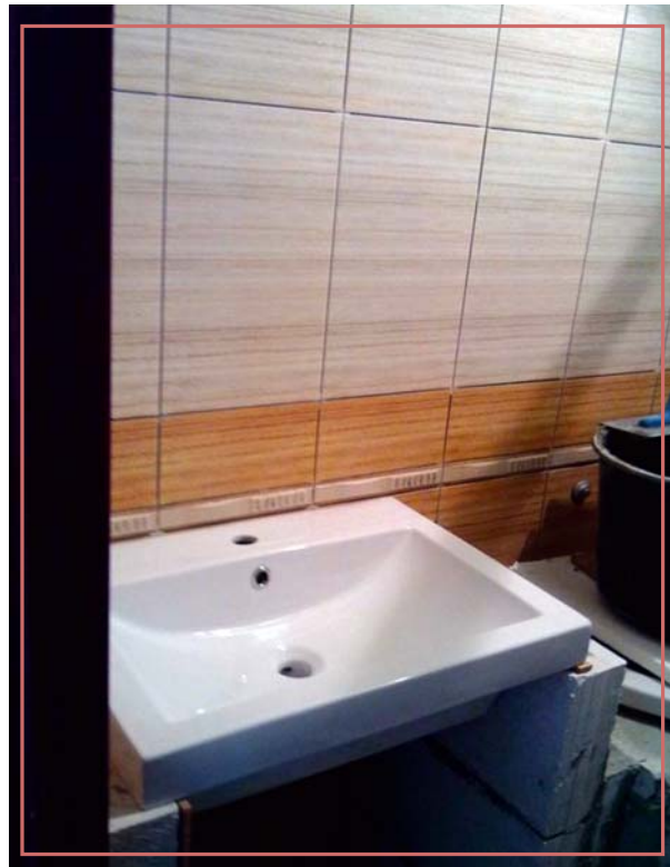
Příprava obkladů pro spárování
