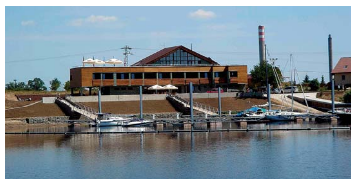
Přístav pro osobní lodě na Labi a hotel Marina v Pištěnech, na které byla poskytnuta dotace ze strukturálních fondů EU a Ústeckého kraje
