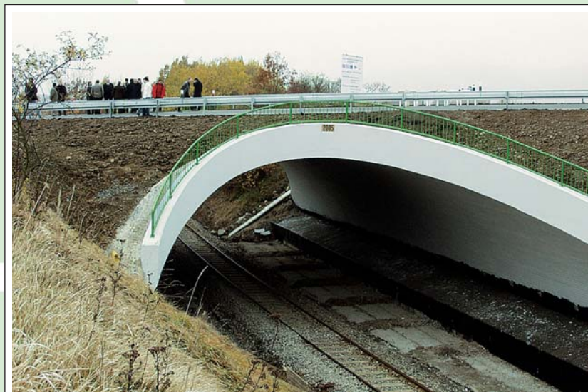
LISTOPAD Řidičům byl předán do užívání otevřen nový silniční most přes železniční trať na silnici II/528 u obce Žďárek na Ústecku. Realizace Žďáreckého mostu představuje unikátní stavbu, realizovanou za 28 milionů z prostředků Ústeckého kraje
