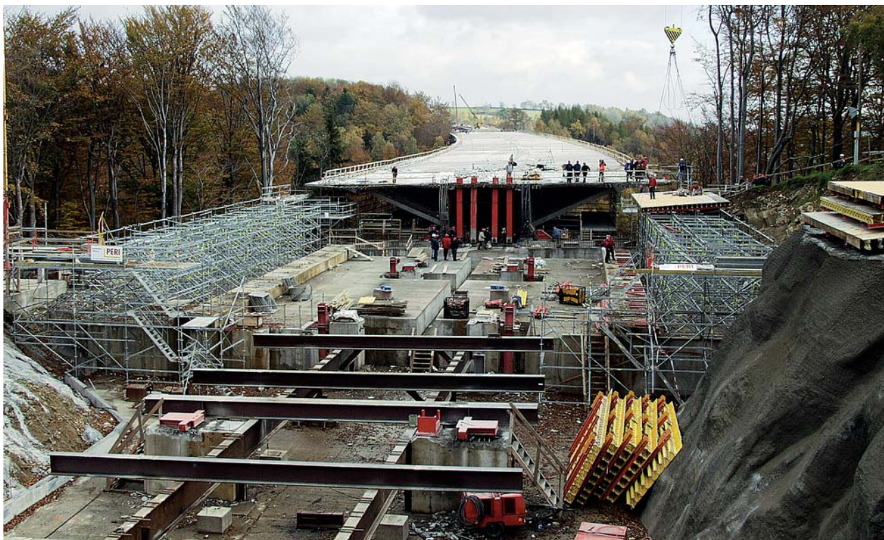
Velký pokrok zaznamenala v letošním roce stavba dálnice D8 v úseku Trmice – státní hranice
