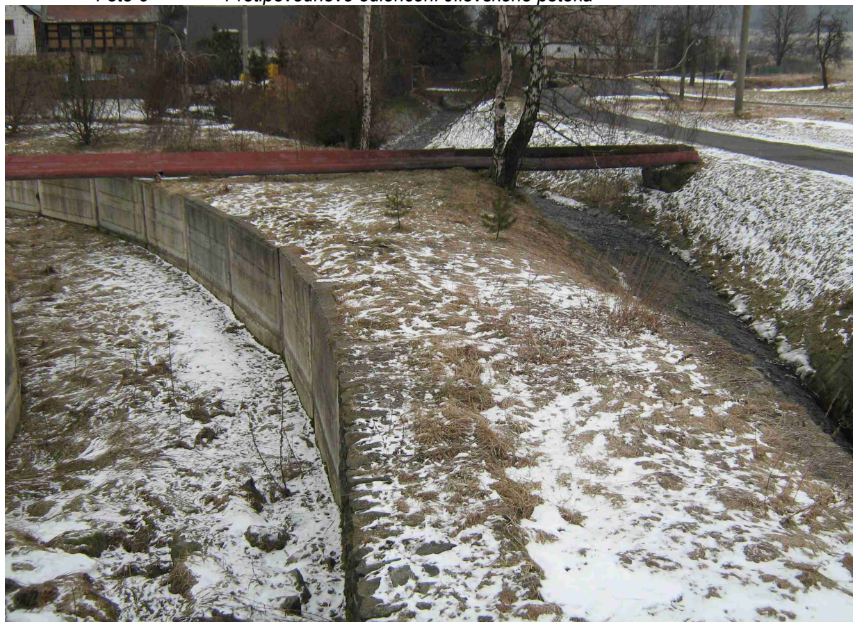
Foto 6 Protipovodňové odlehčení Jílovského potoka
