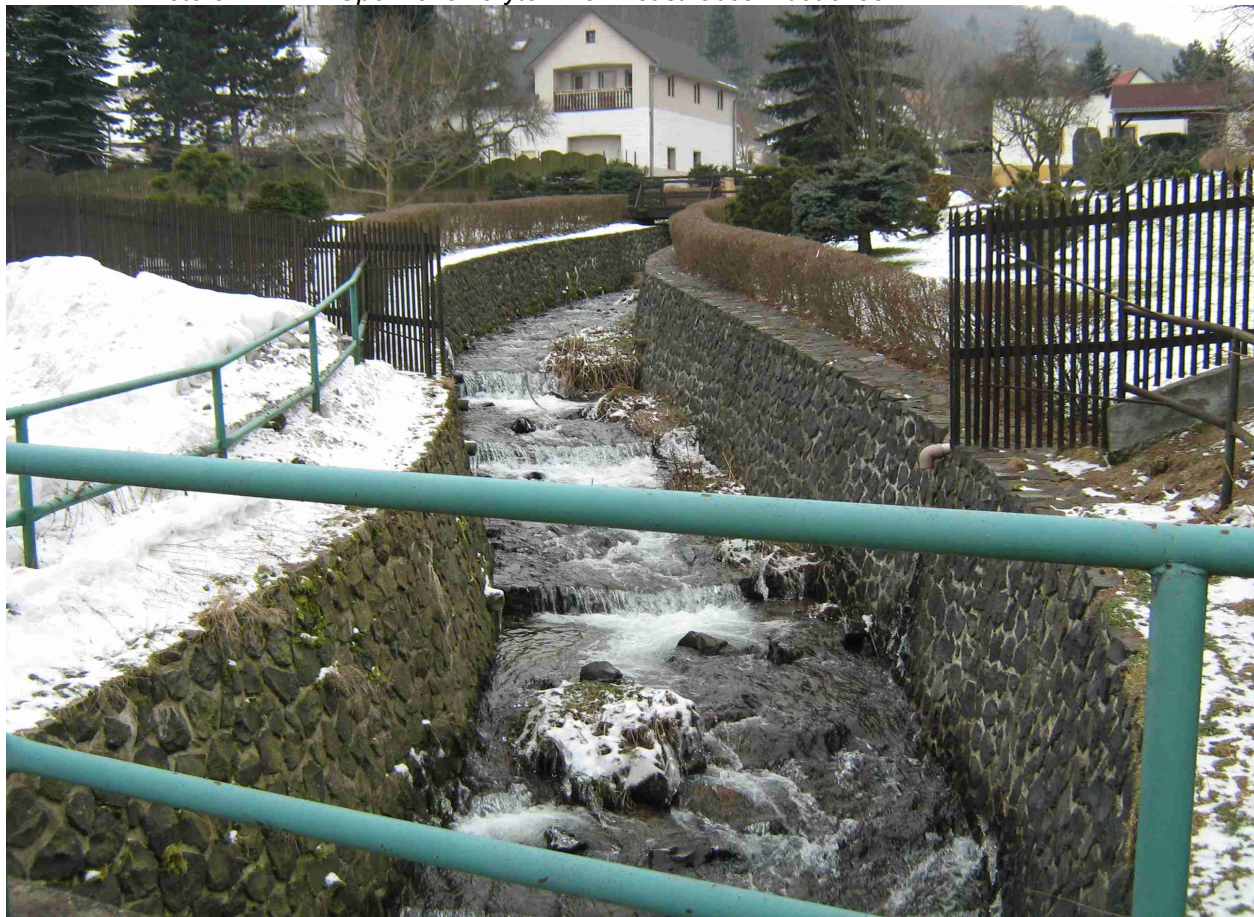
Foto 6 Protipovodňové odlehčení Jílovského potoka
