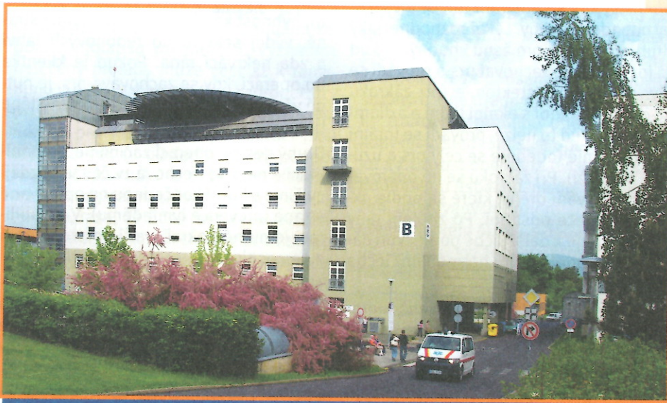
Budova B s heliportem v Masarykově nemocnici v Ústí nad Labem, o. z.
