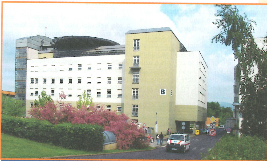
Budova B s heliportem v Masarykově nemocnici v Ústí nad Labem, o. z.
