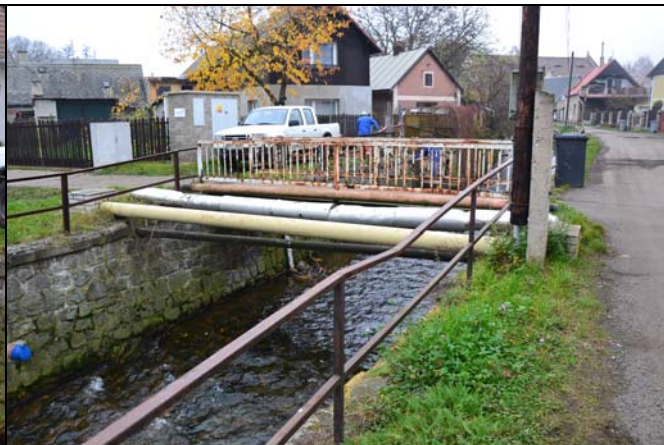
pohled z dolní vody na objekt
