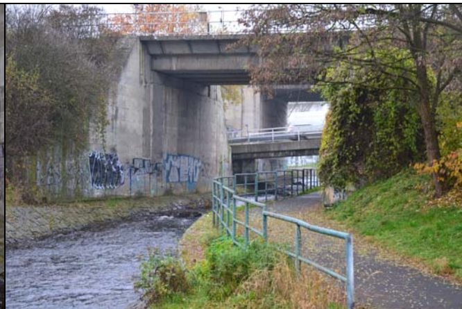
pohled z dolní vody na objekt
