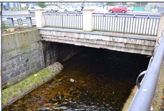
pohled z dolní vody na objekt
