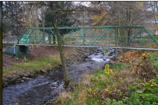
pohled z dolní vody na objekt
