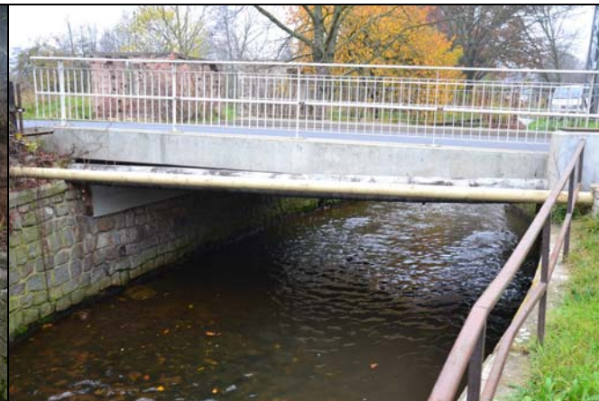
pohled z dolní vody na objekt
