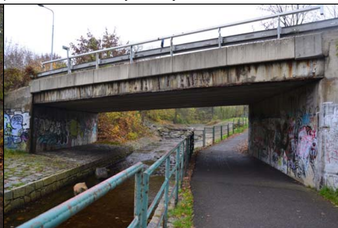
pohled z dolní vody na objekt
