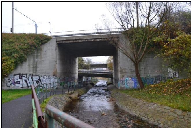
pohled z horní vody na objekt
