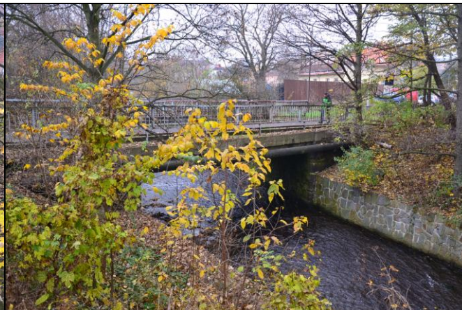
pohled z dolní vody na objekt
