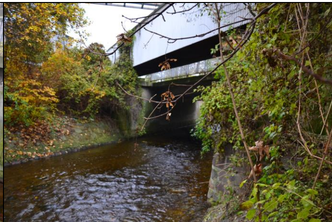
pohled z dolní vody na objekt
