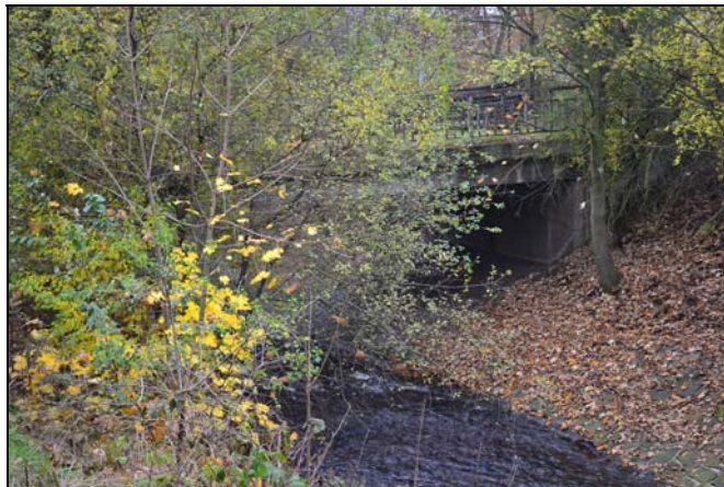
pohled z horní vody na objekt
