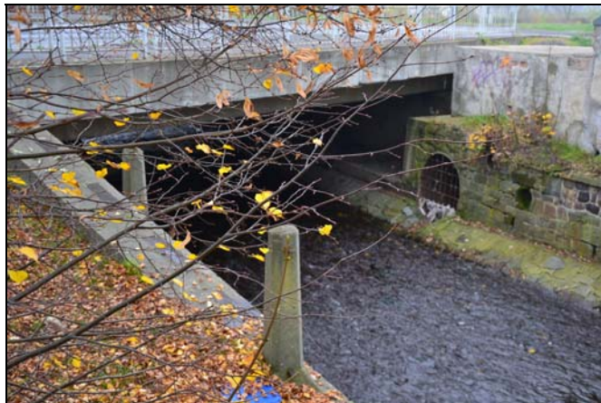
pohled z horní vody na objekt
