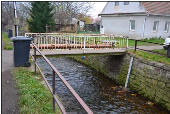
pohled z horní vody na objekt
