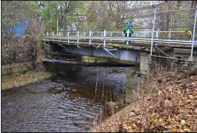
pohled z horní vody na objekt
