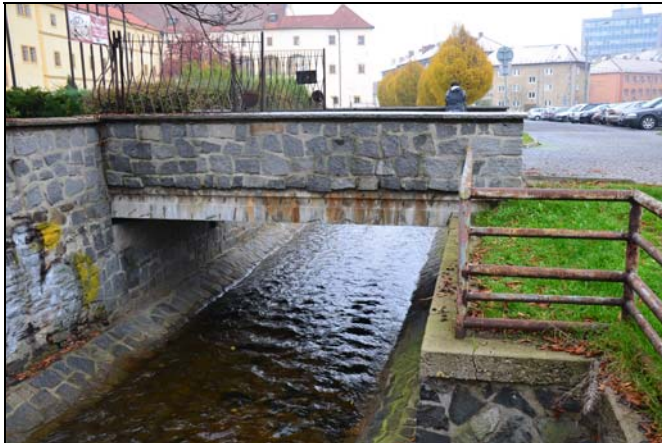
pohled z horní vody na objekt
