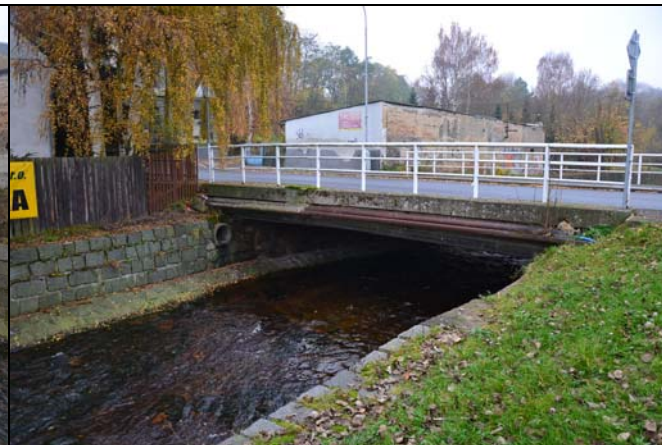
pohled z dolní vody na objekt
