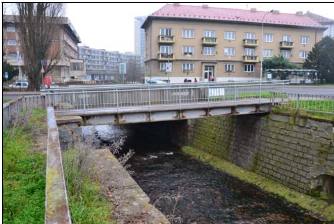
pohled z horní vody na objekt
