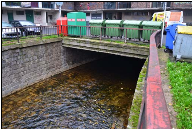
pohled z horní vody na objekt
