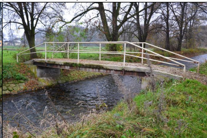
pohled z dolní vody na objekt
