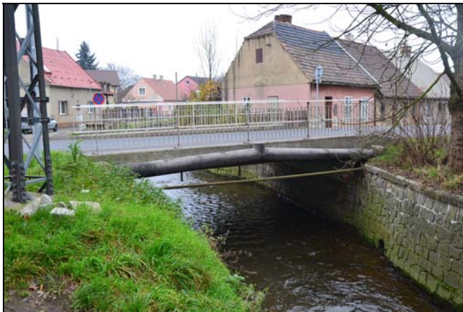
pohled z horní vody na objekt
