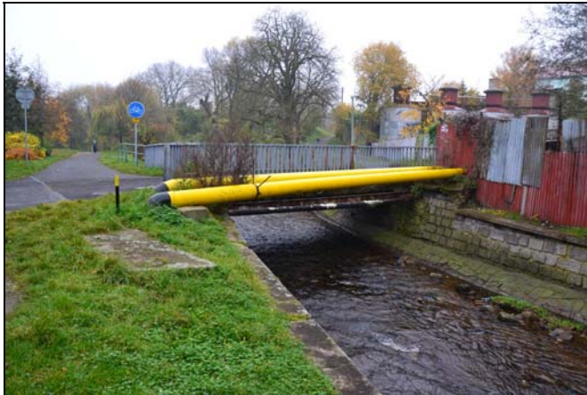
pohled z horní vody na objekt
