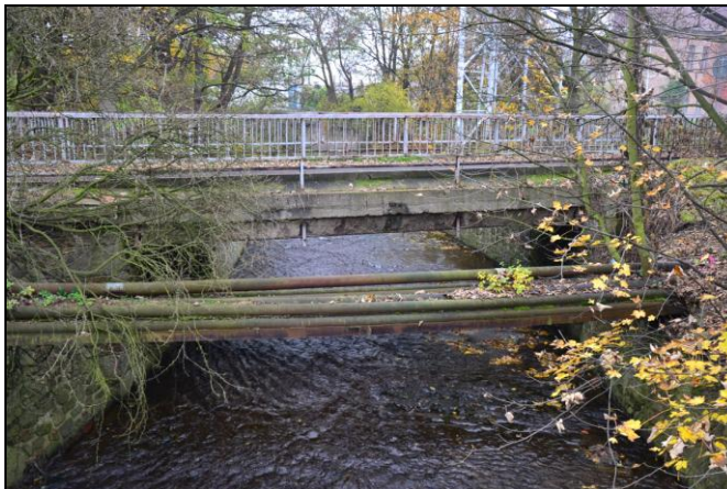
pohled z horní vody na objekt
