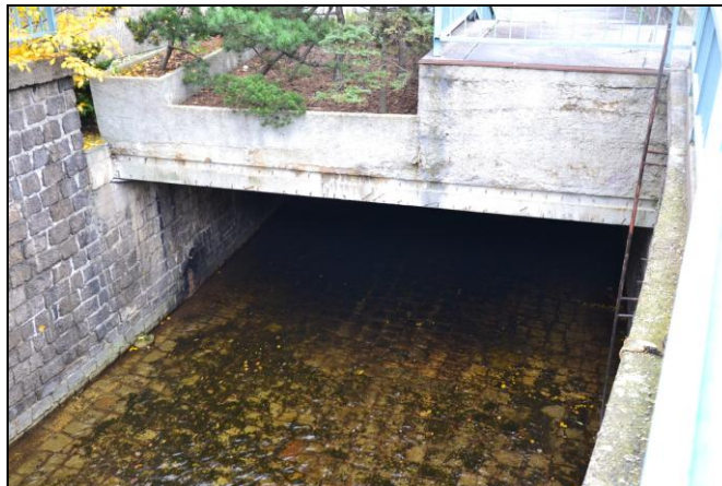
pohled z horní vody na objekt
