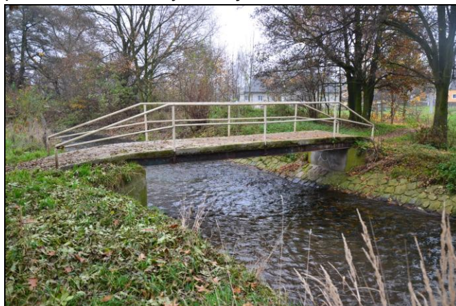
pohled z horní vody na objekt
