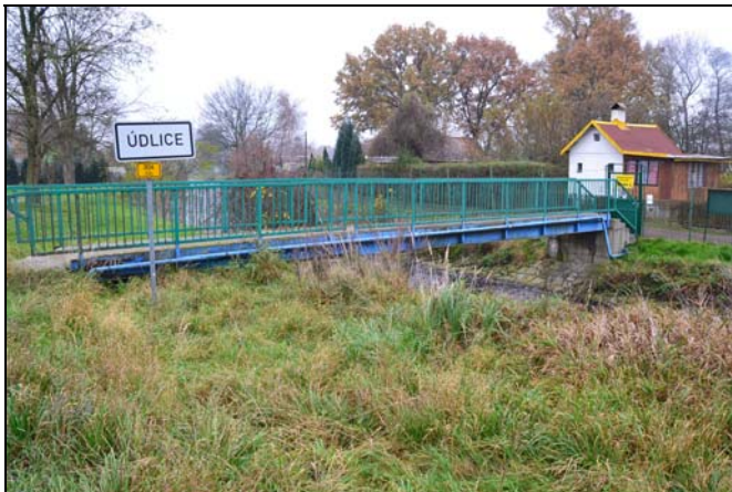
pohled z horní vody na objekt
