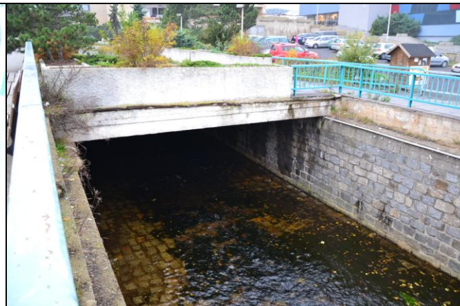
pohled z dolní vody na objekt
