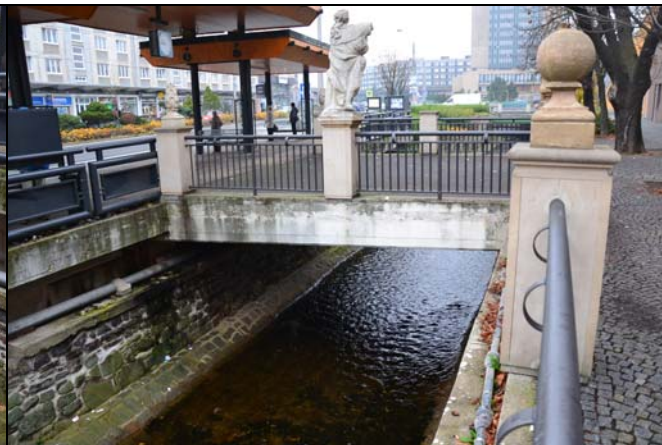
pohled z dolní vody na objekt
