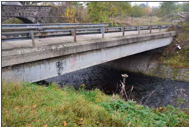
pohled z horní vody na objekt
