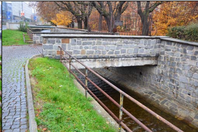
pohled z dolní vody na objekt
