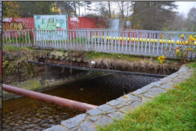
pohled z dolní vody na objekt
