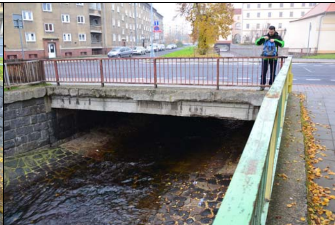
pohled z dolní vody na objekt
