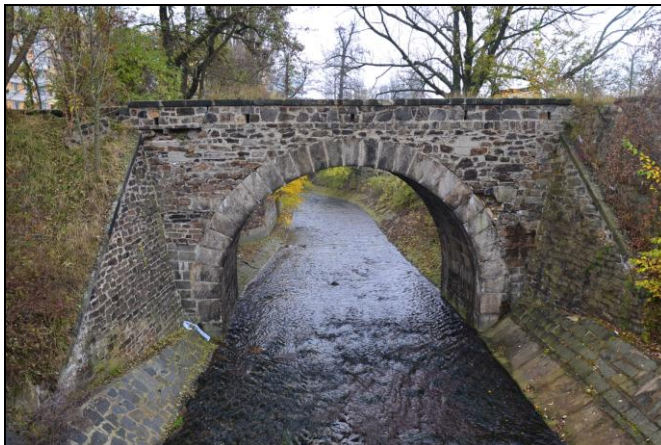
pohled z horní vody na objekt
