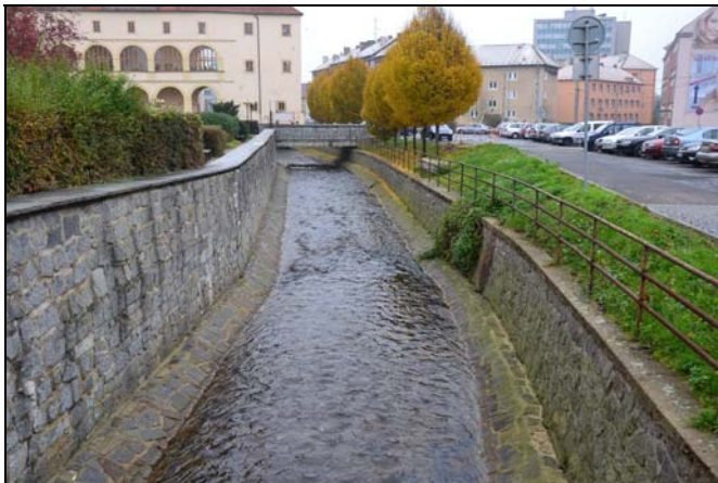
pohled na koryto z (od) objektu po vodě
