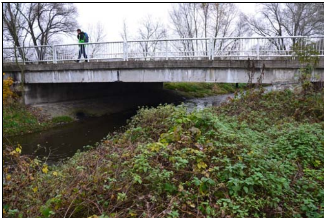
pohled z horní vody na objekt
