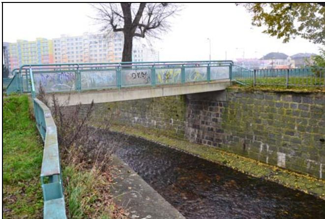
pohled z horní vody na objekt
