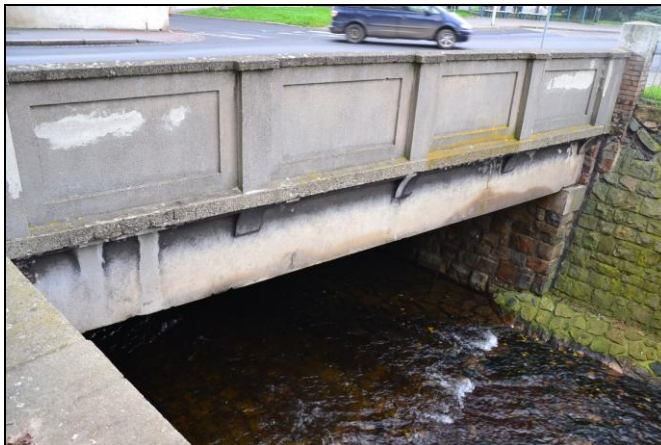
pohled z horní vody na objekt
