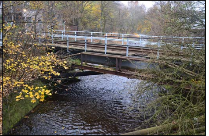
pohled z dolní vody na objekt
