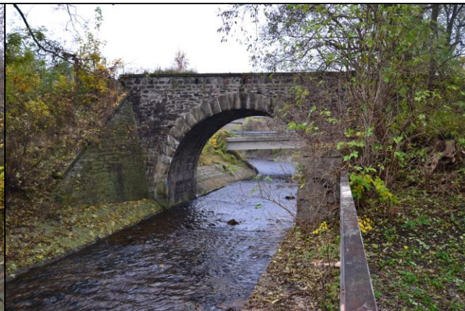
pohled z dolní vody na objekt
