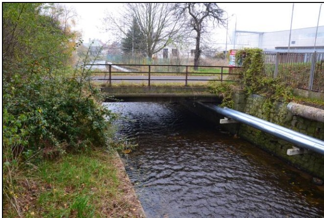
pohled z horní vody na objekt
