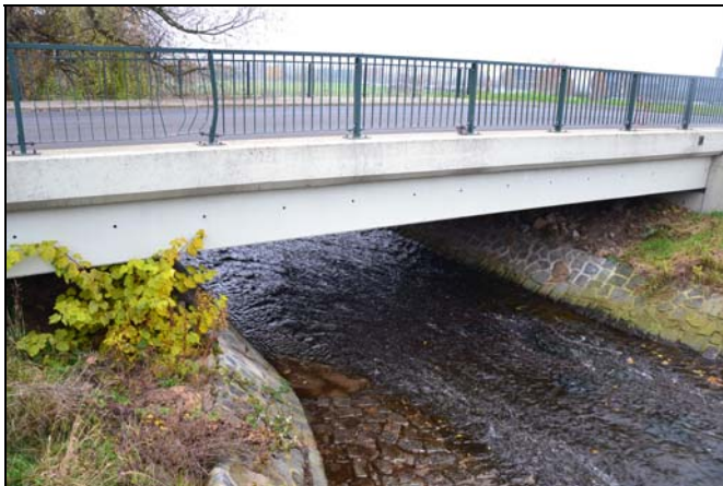
pohled z horní vody na objekt
