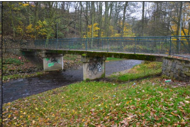
pohled z dolní vody na objekt
