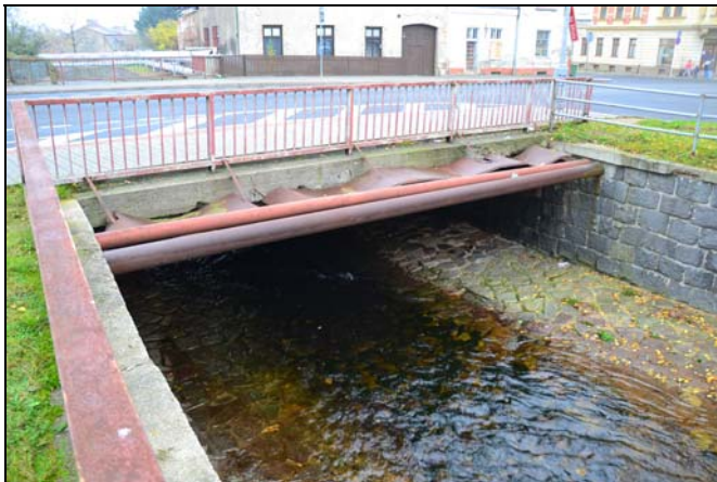
pohled z horní vody na objekt
