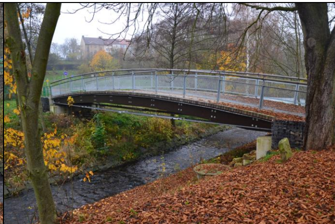
pohled z dolní vody na objekt
