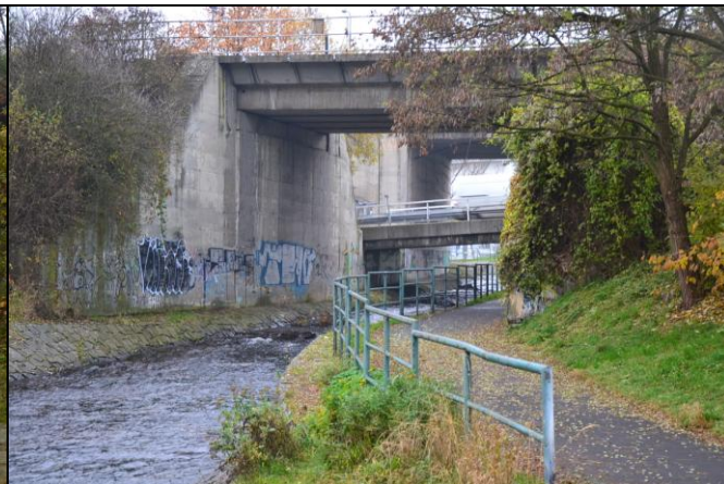
pohled z dolní vody na objekt
