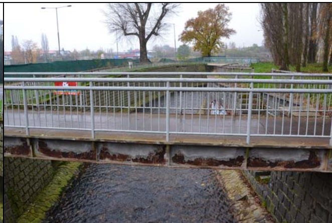
pohled z dolní vody na objekt
