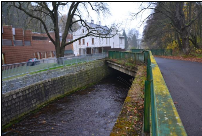
pohled z horní vody na objekt
