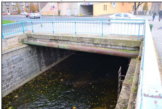
pohled z horní vody na objekt
