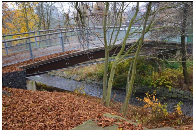
pohled z horní vody na objekt
