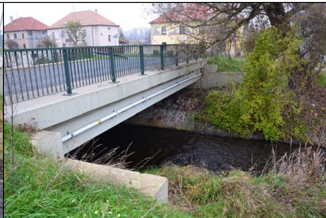
pohled z dolní vody na objekt
