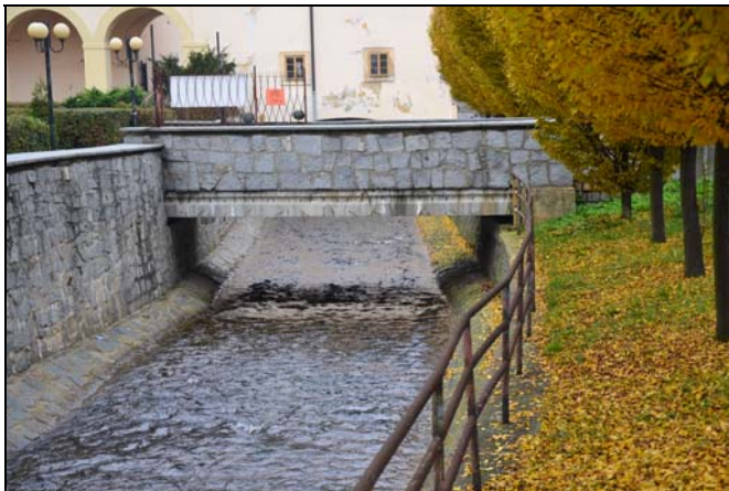
pohled z horní vody na objekt
