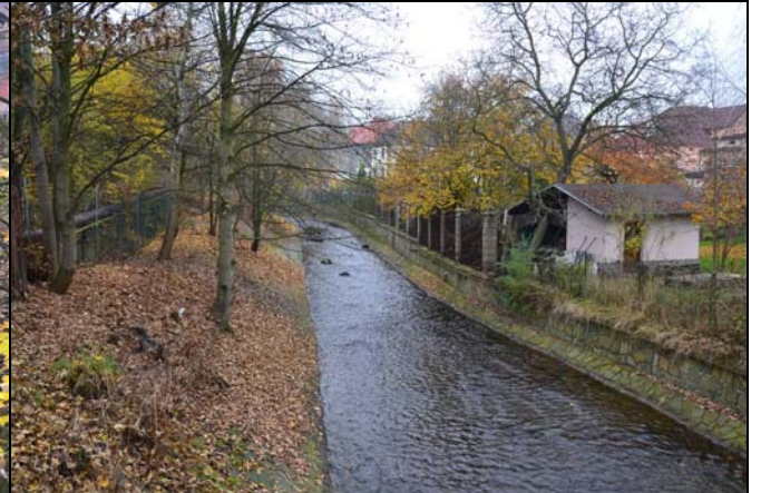
pohled na koryto z (od) objektu proti vodě
