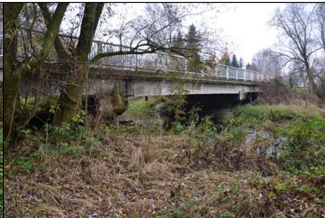
pohled z dolní vody na objekt
