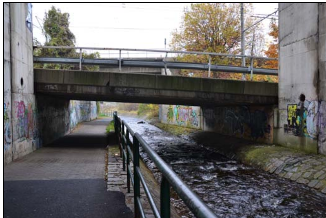
pohled z horní vody na objekt
