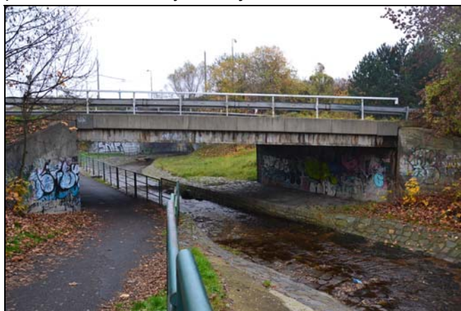
pohled z horní vody na objekt
