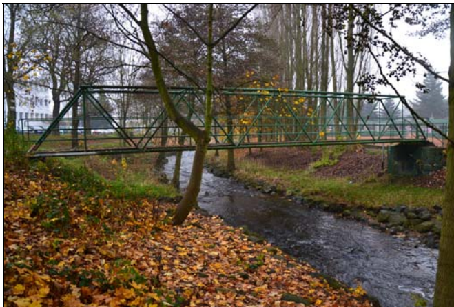
pohled z horní vody na objekt
