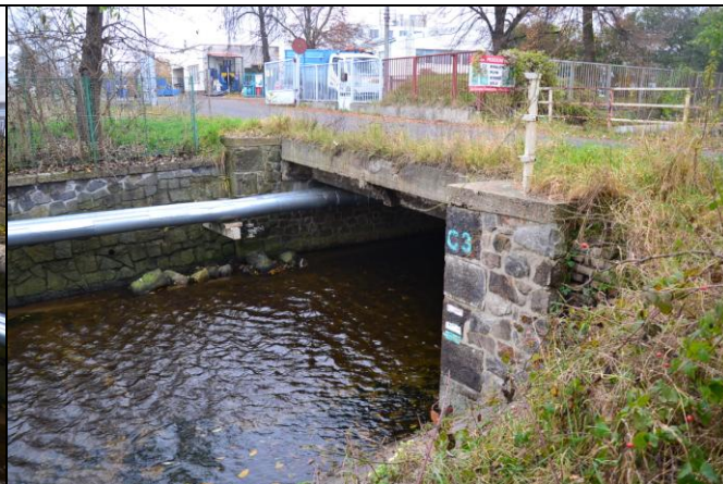
pohled z dolní vody na objekt
