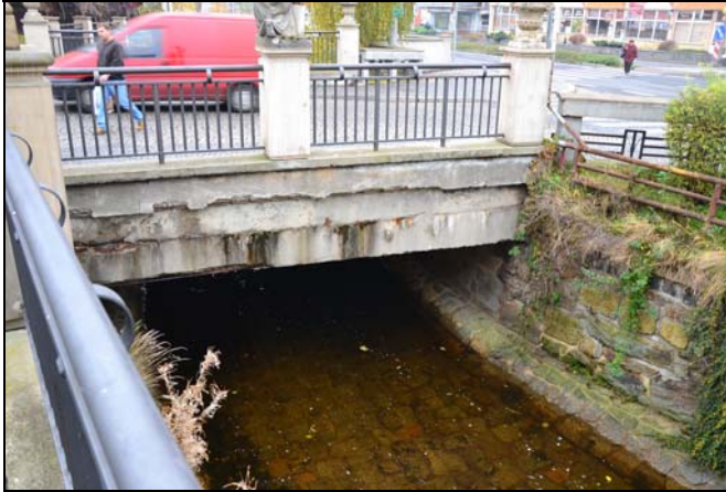
pohled z horní vody na objekt
