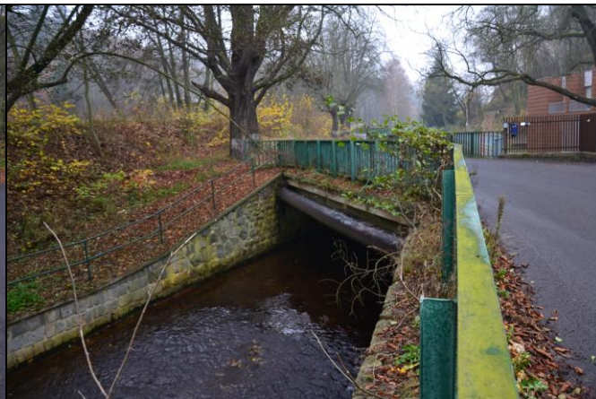
pohled z dolní vody na objekt
