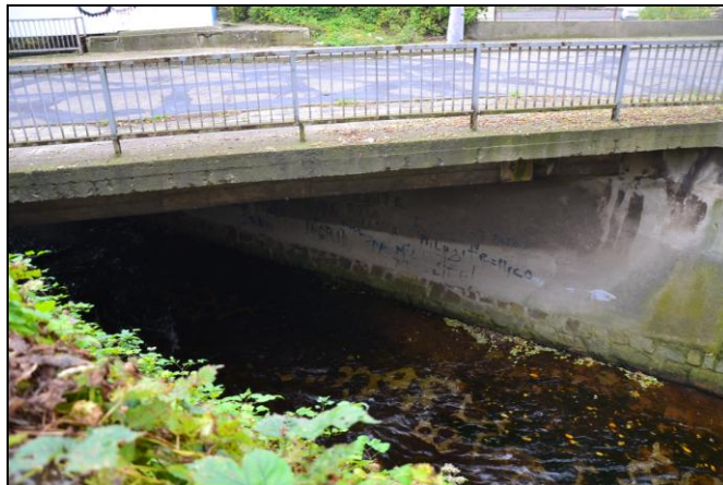
pohled z horní vody na objekt
