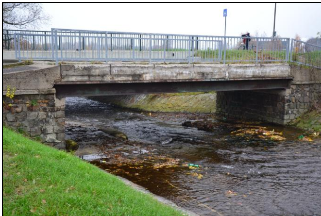
pohled z horní vody na objekt
