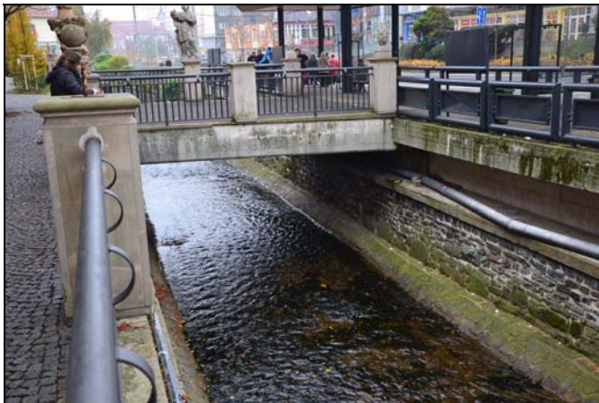
pohled z horní vody na objekt
