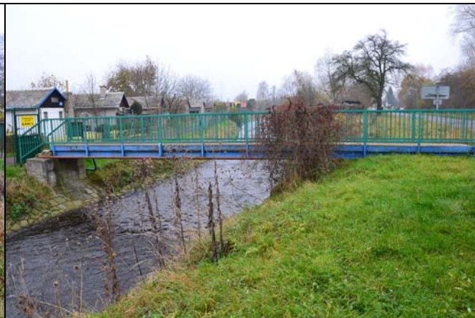
pohled z dolní vody na objekt
