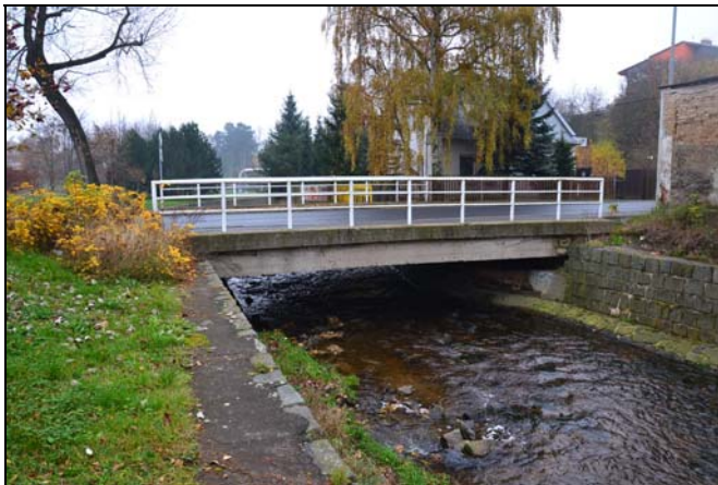
pohled z horní vody na objekt
