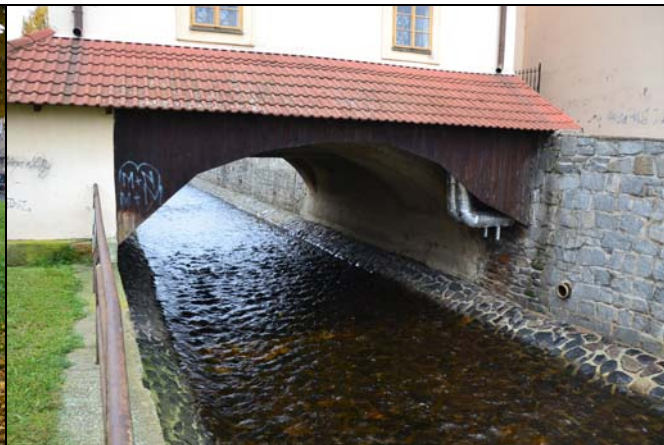
pohled z dolní vody na objekt
