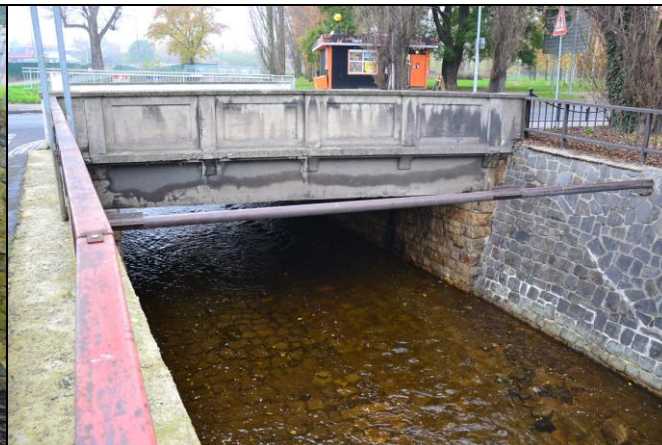
pohled z dolní vody na objekt
