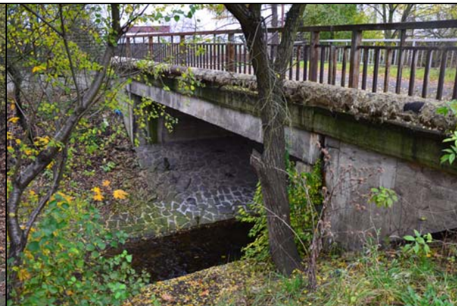
pohled z dolní vody na objekt
