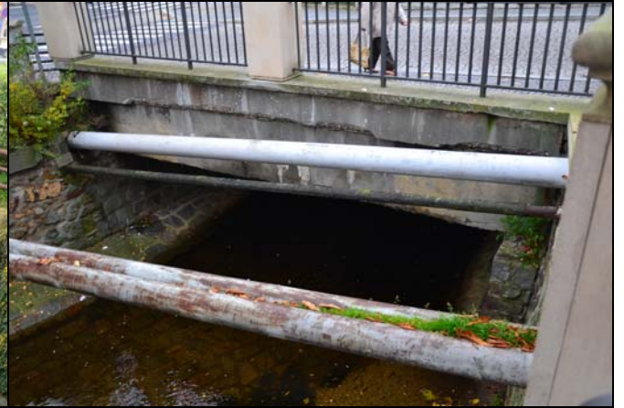
pohled z dolní vody na objekt
