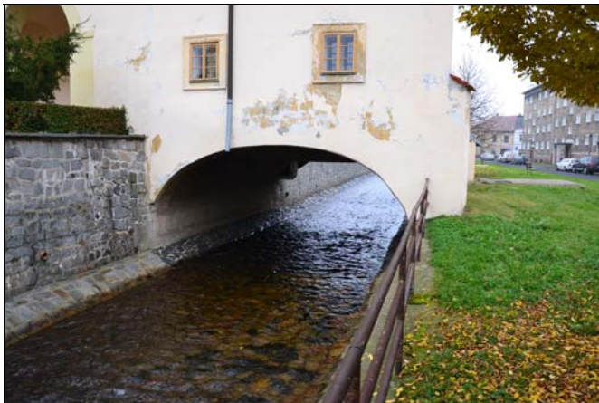
pohled z horní vody na objekt
