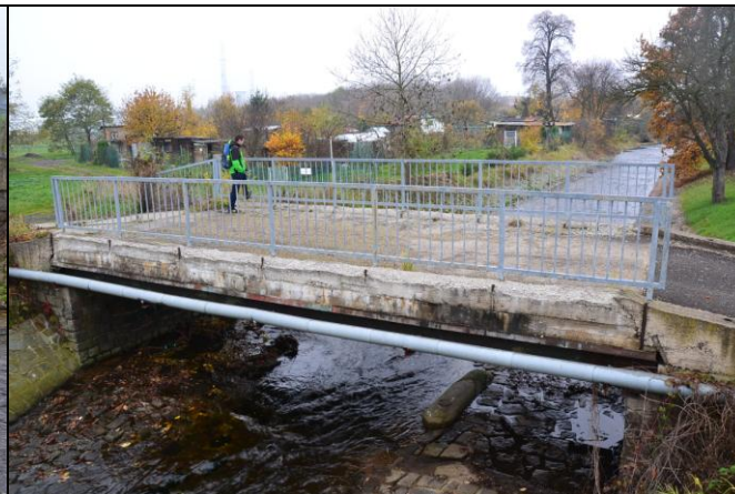
pohled z dolní vody na objekt
