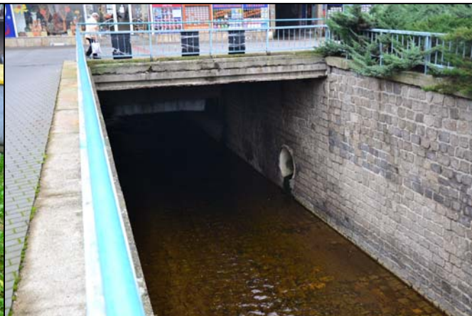
pohled z dolní vody na objekt
