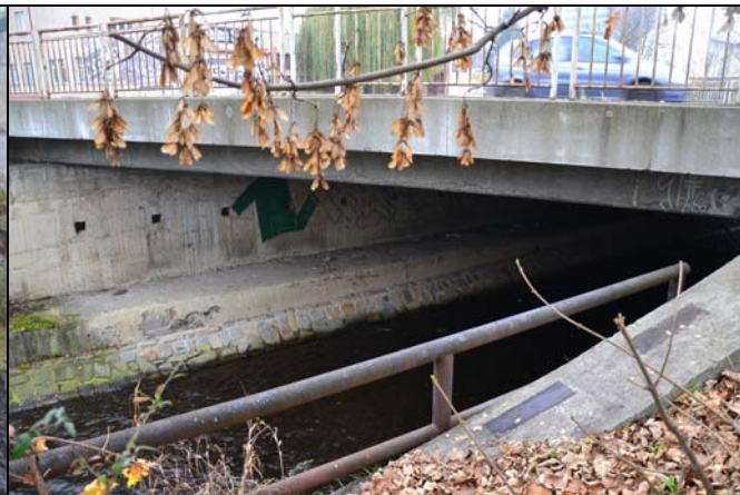
pohled z dolní vody na objekt
