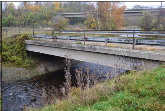
pohled z dolní vody na objekt
