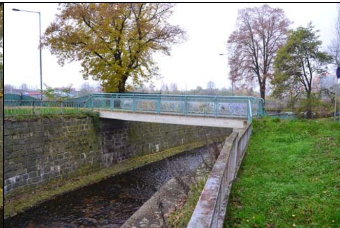
pohled z dolní vody na objekt
