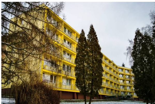
Zateplení budovy Křížatecká 16
