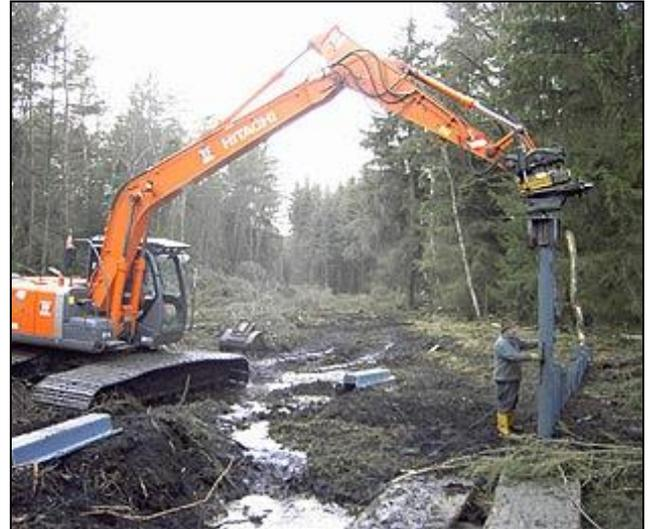
Abbildung 4: Manueller Einbau einer Kunststoff-Spundwand in Litauen (links aus KOZULIN et al. 2010) und maschineller Einbau im Pfrunger-Burgweiler Ried (rechts, Foto: Bernd Reißmüller, Internetseite des Naturschutzgroßprojektes).
