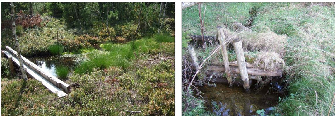
Abbildung 1: Spundwand vor Torfüberdeckung (links) und umspülter Rundholzdamm (rechts).
