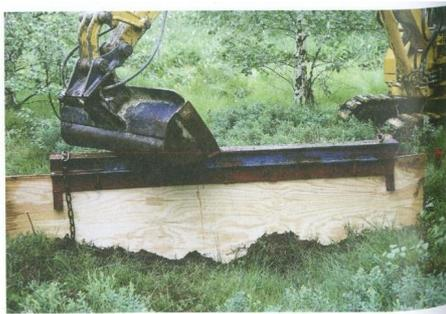
Abb. 75 Einsetzen der Platte und des Metallprofils mithilfe des Kleinbaggers
