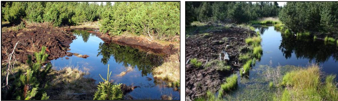
Abbildung 9: Erdwall und aufgestaute Fläche nach Baggereinsatz in der Mittelrinne der „Gabelhaide“. Links nach dem Bau (15.11.2009); rechts zum Zeitpunkt der Gutachtenerstellung (7.7.2011)
