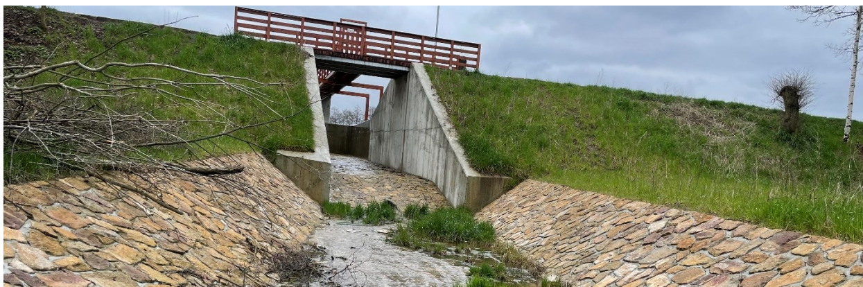
Obrázek 14 – Nový BP Proboštovského rybníka a odpadní koryto, které se vlévá zpět do obtokového koryta na Obr. 13. Soutok se nachází v místě, z kterého byla fotografie pořízena.
