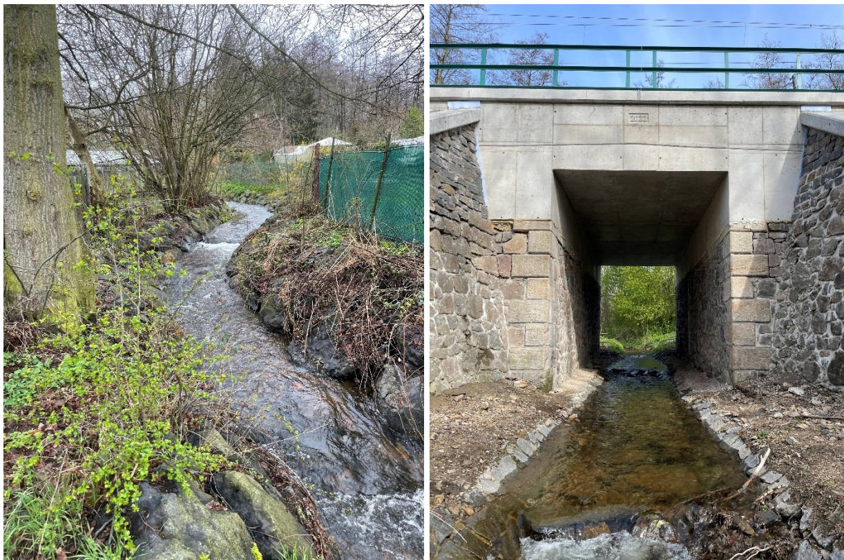
Obrázek 15, 16 – (vlevo) Kamenná rovnanina u zahr. kolonie. (vpravo) Zrekonstruovaný železniční most.
