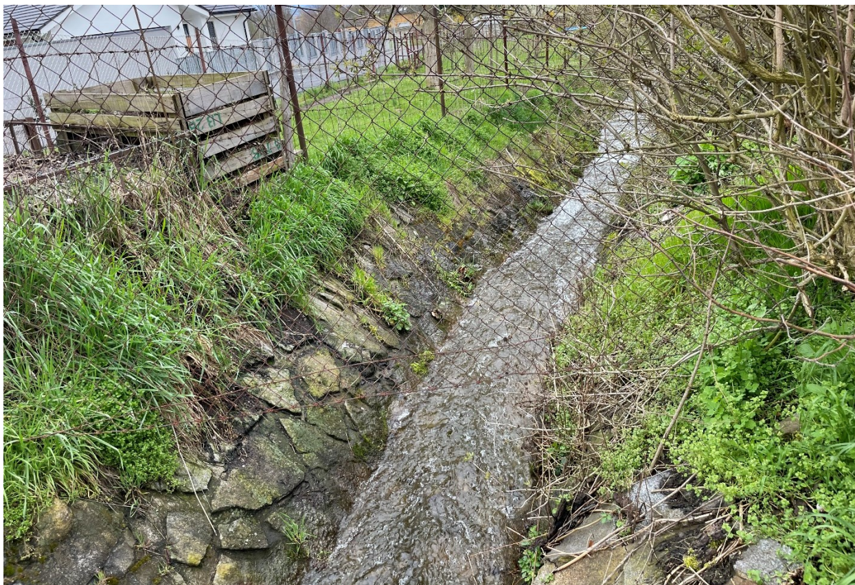
Obrázek 60 - Přeplocení odtokového profilu. Po cca 50 metrech se situace opakuje.
