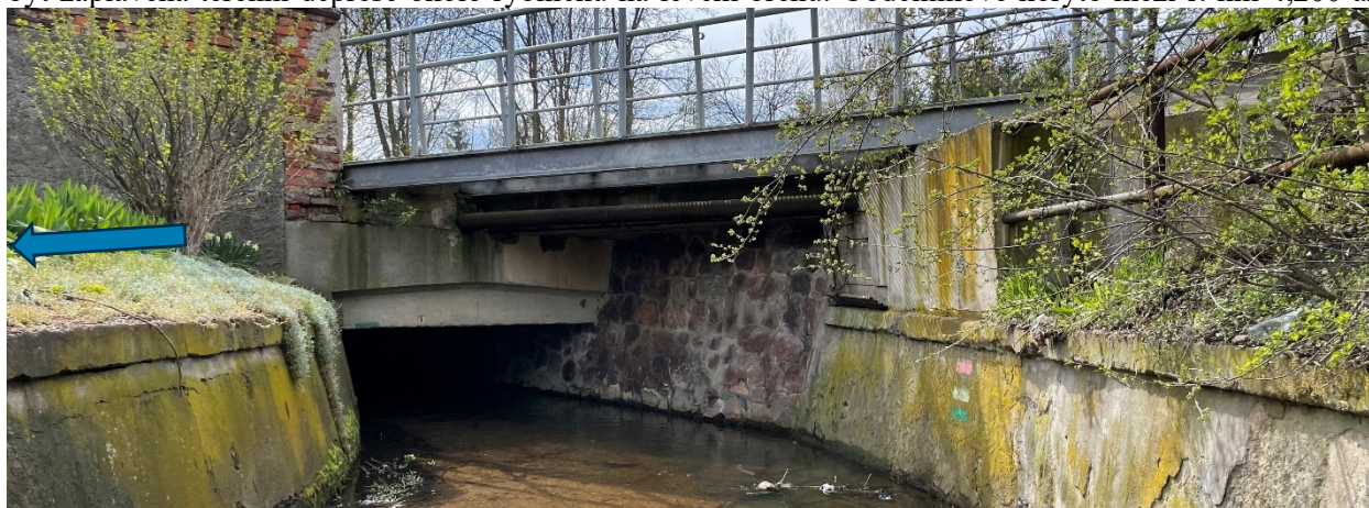
Obrázek 54 Předpoklad levobřežního vybřežení je patrný i z této fotografie. Nárazový pravý břeh je výrazně vyvýšen z důvodu přítomnosti komunikace.
