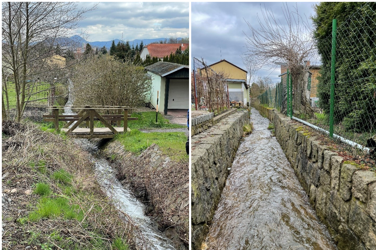
Obrázek 5 a 6 – (vlevo) Po několika stupních ve dně přechází koryto z lichoběžníkového (za lávkou) na obdélníkové zděné koryto (vpravo).
