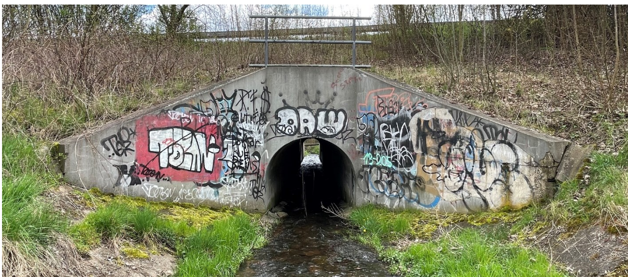
Obrázek 23 – Propustek s kapacitou cca 9 – 10 m 3 /s.
