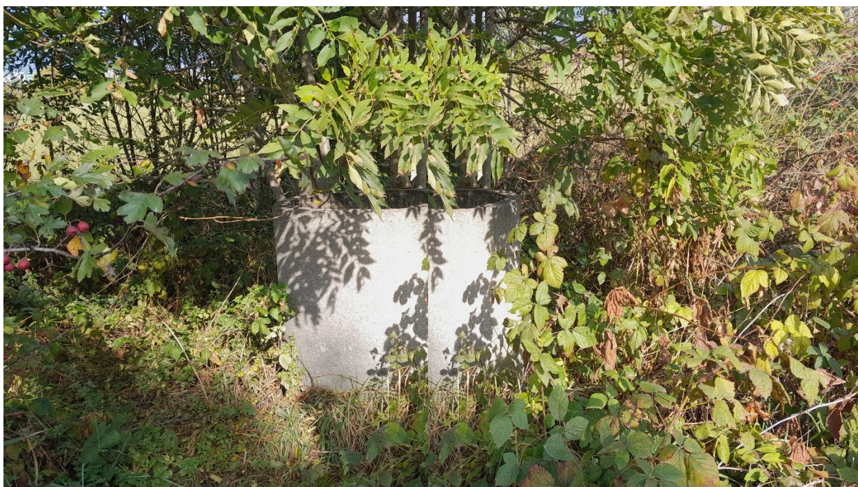
Obrázek 56 Předpokládaný vtok do propustku pod I/13 odvodňující lokalitu „U Nových Srbic“ DN 1000.
