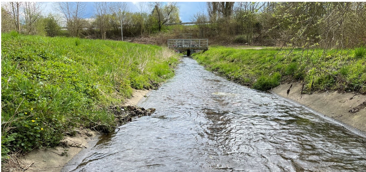
Obrázek 22 – Lichoběžníkové koryto opevněné betonovými panely.
