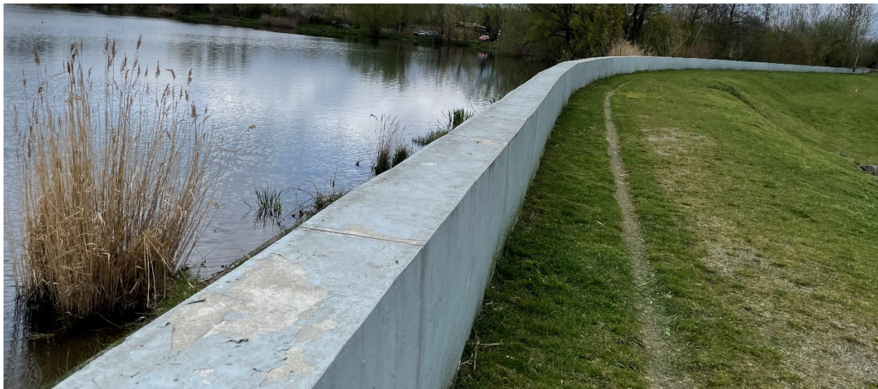
Obrázek 30 – Vlnolam na návodní straně hráze VD Modlany.
