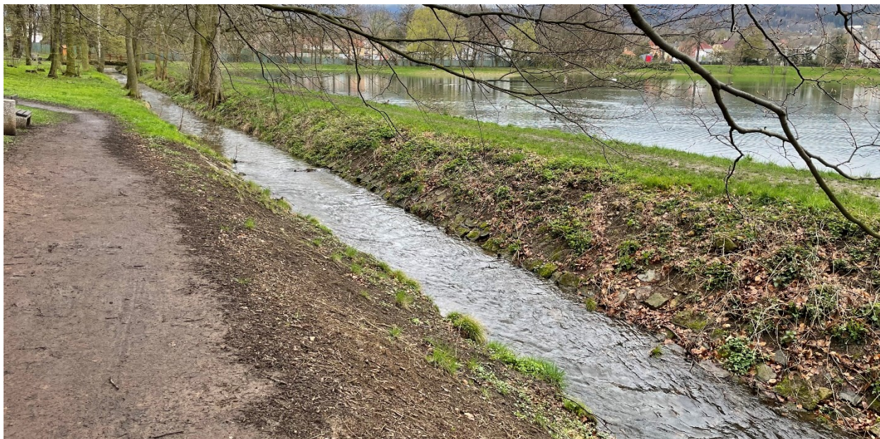
Obrázek 11 – Proboštovský rybník je boční nádrž na Modlanském potoce. Koryto nádrž obtéká.
