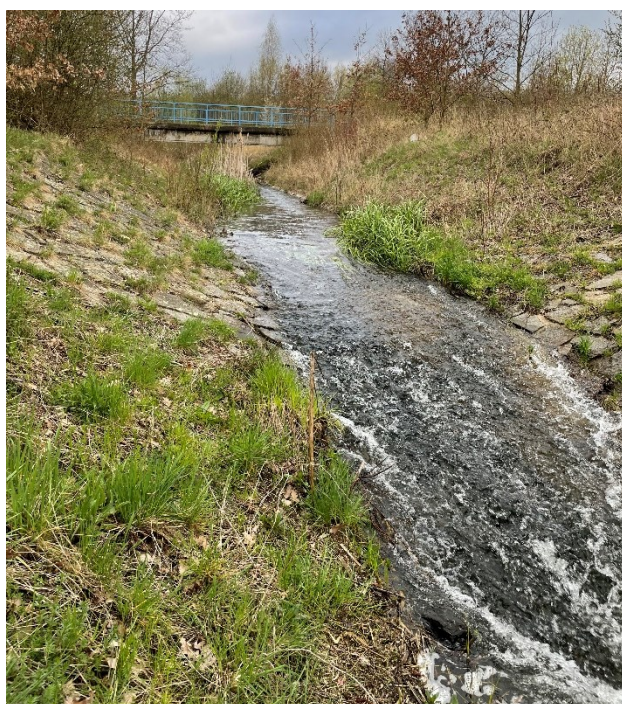
Obrázek 31, 32 – Vtok do nádrže Kateřina má větší sklon (na obrázku je patrná změna režimu proudění).
