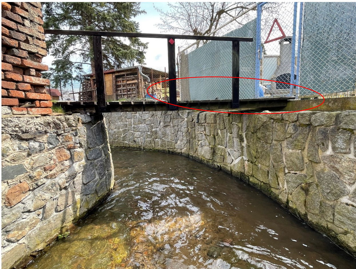
Obrázek 58 Předpoklad pravobřežního vybřežení je patrný i z této fotografie (směrem nárazového břehu, voda proudí od pohledu fotografa)
