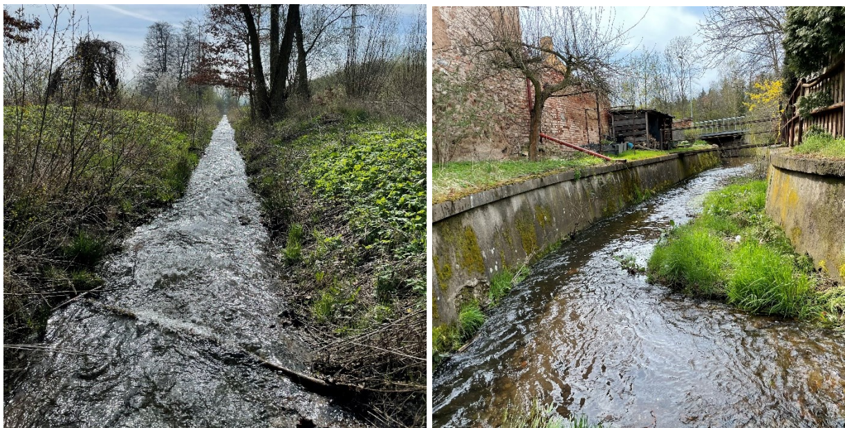
Obrázek 17, 18 – (vlevo) Přímé lichoběžníkové koryto u nádrže „Na Centrále“ (vpravo) Přejít do intravilánu změna na obdélníkové koryto s opěrnými zdmi.
