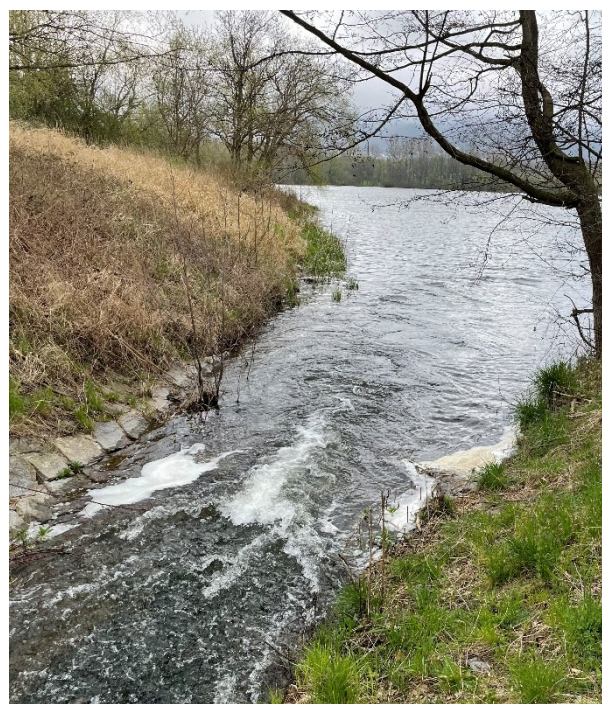
Obrázek 31, 32 – Vtok do nádrže Kateřina má větší sklon (na obrázku je patrná změna režimu proudění).
