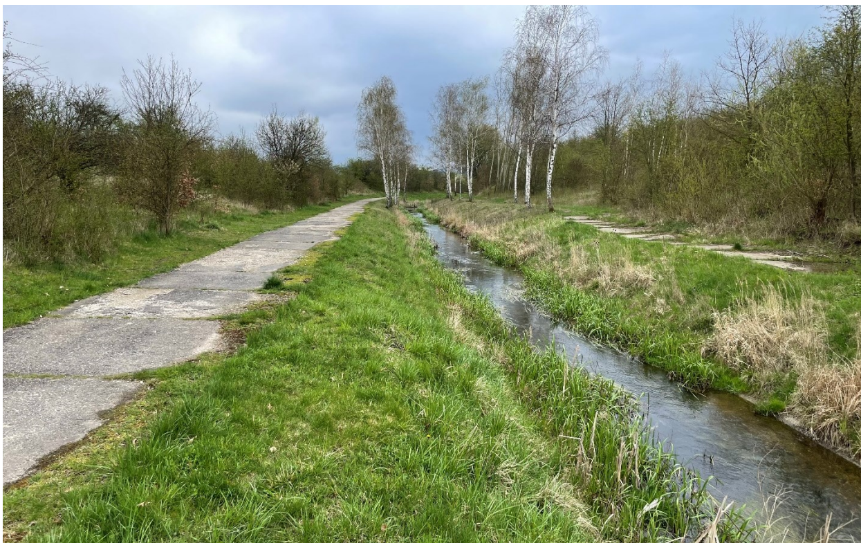
Obrázek 29 – Přivaděč od VD Modlany k VD Kateřina je v celé délce (1km) proveden jako technické prizmatické koryto s kynetou a bermami.
