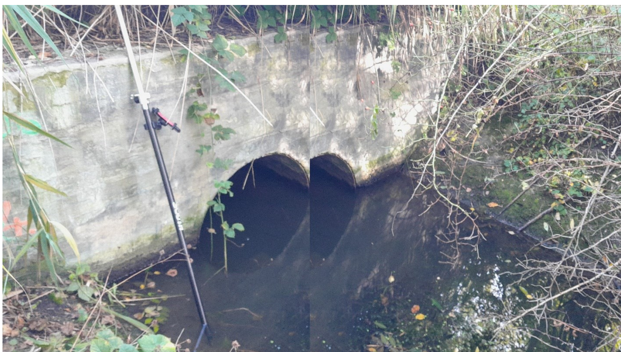
Obrázek 57 Propustek na HOP odvodňující lokalitu „U Nových Srbic“ DN 1000. Prokazatelně zde proudí průsaková voda, takže nebude propustek zanesen.
