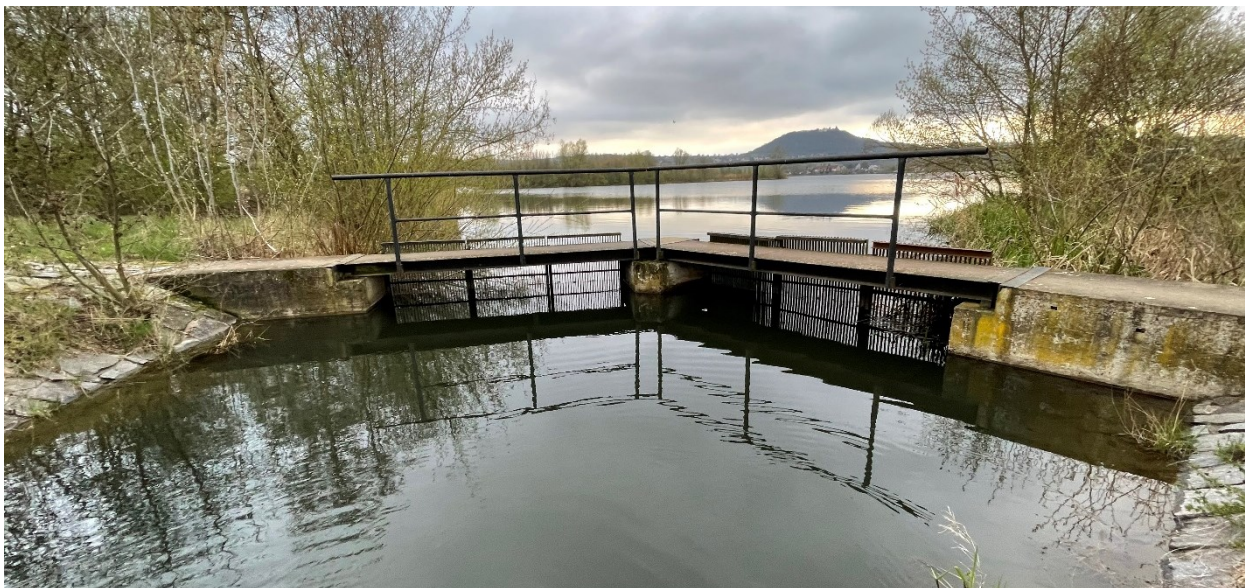
Obrázek 28 – Bezpečnostní přeliv VD Modlany. Hladina v nádrži je přímo napojena na koryto. Odtok z BP je řízen kapacitou koryta a samotnou transformací TPV retenčním prostorem nádrže.
