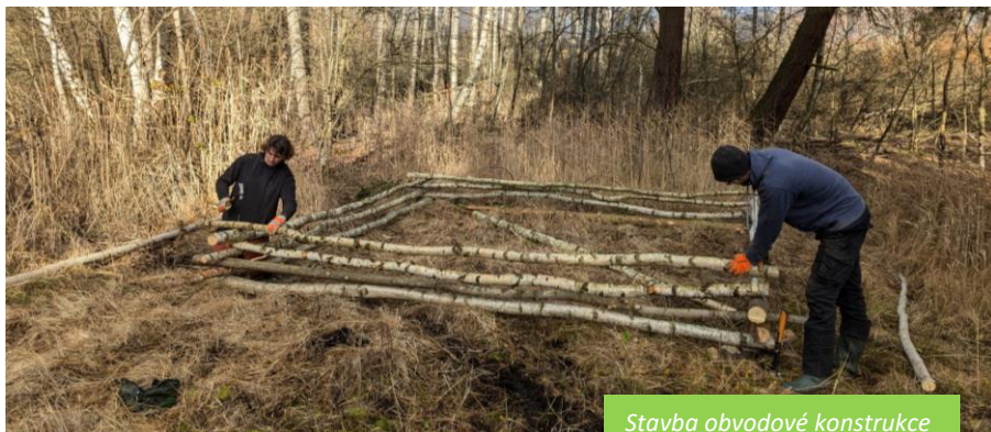
Stavba obvodové konstrukce
