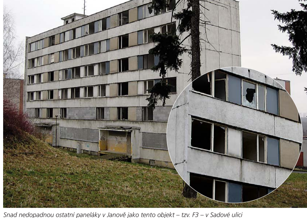
Snad nedopadnou ostatní paneláky v Janově jako tento objekt – tzv. F3 – v Sadové ulici
