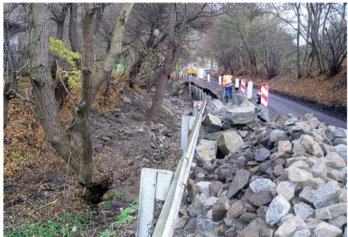
Práce na sanaci a opěrné zdi na silnici III/24721 Sebusín – Litoměřice
