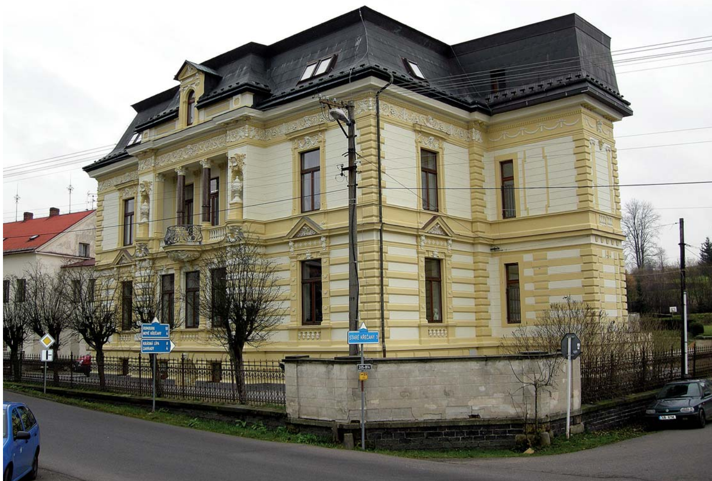
Rekonstrukční práce největšího objektu ÚSP v Brtníkách přišly Ústecký kraj na 43 milionů korun
