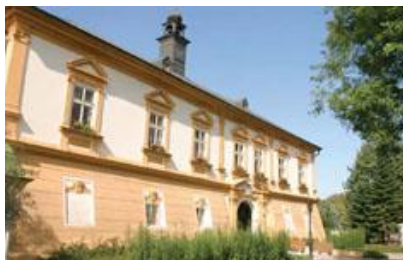
Domov důchodců Čížkovice
