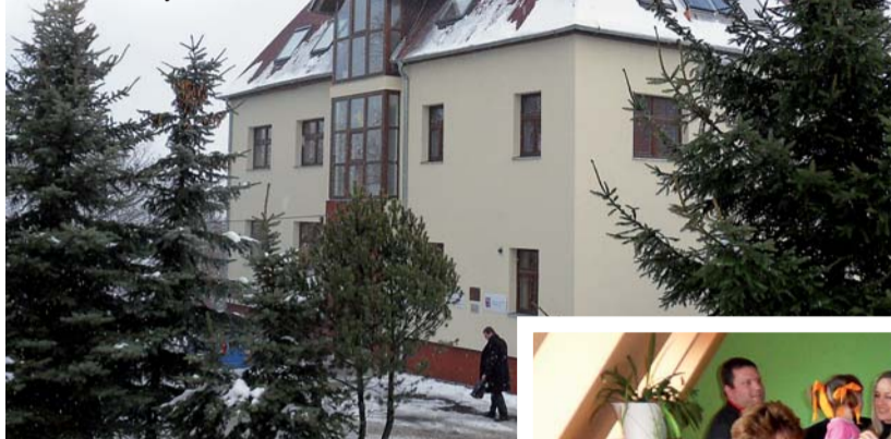
Dětský domov Vysoká Pec 145 po rekonstrukci
