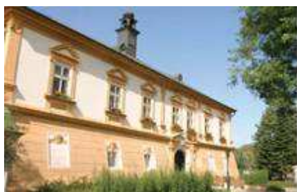
Domov důchodců Čížkovice
