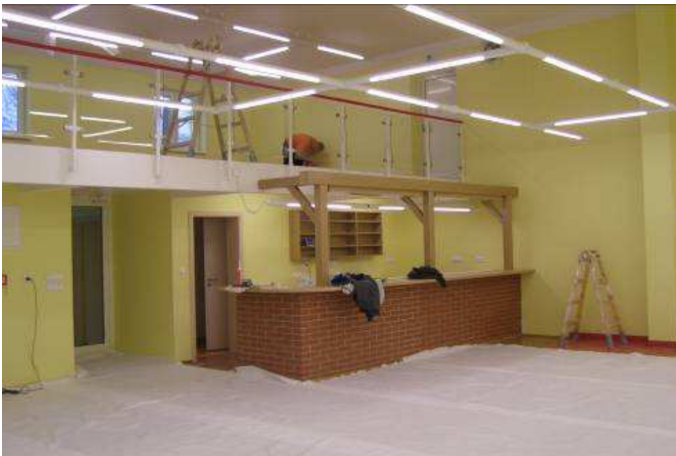
Rekonstrukce kulturní místnosti
