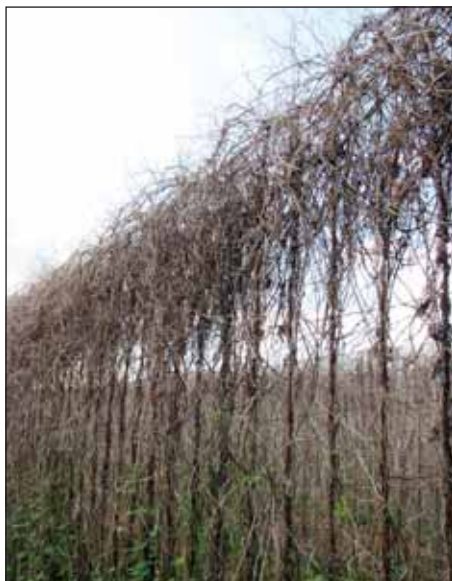
Po očesání mohutné (přehoustlé) chmelové „stěny“ zůstává na konstrukci velké množství rév
