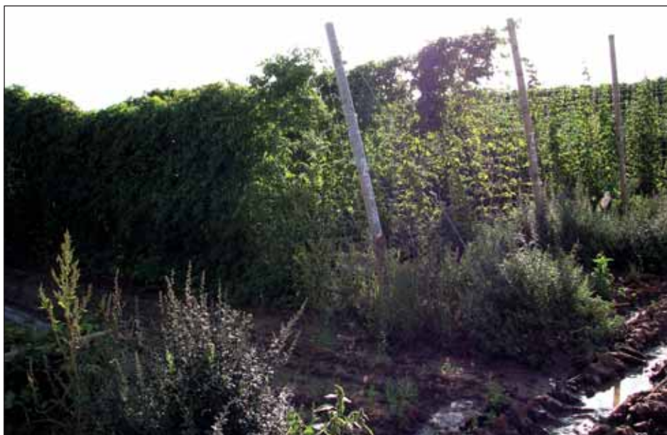
Kolmé upevnění krajních sloupků může způsobit prověšení opěrné sítě až poškození konstrukce
