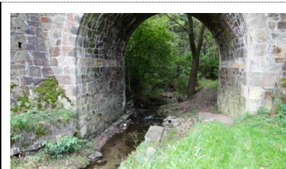
železniční most P51
