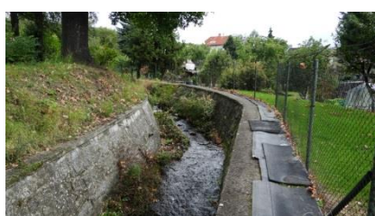
koryto nad mostkem P67
