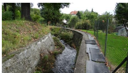
koryto nad mostkem P67
