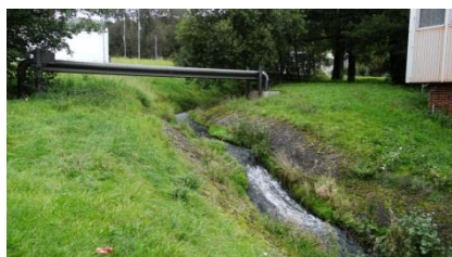
koryto nad mostem P78
