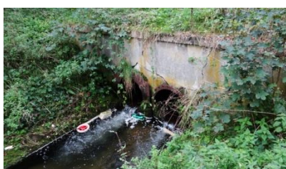
výtok z výpustí VD Loupnice
