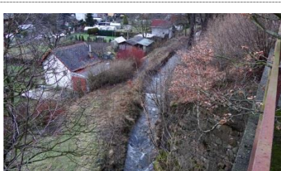
koryto nad mostem P51
