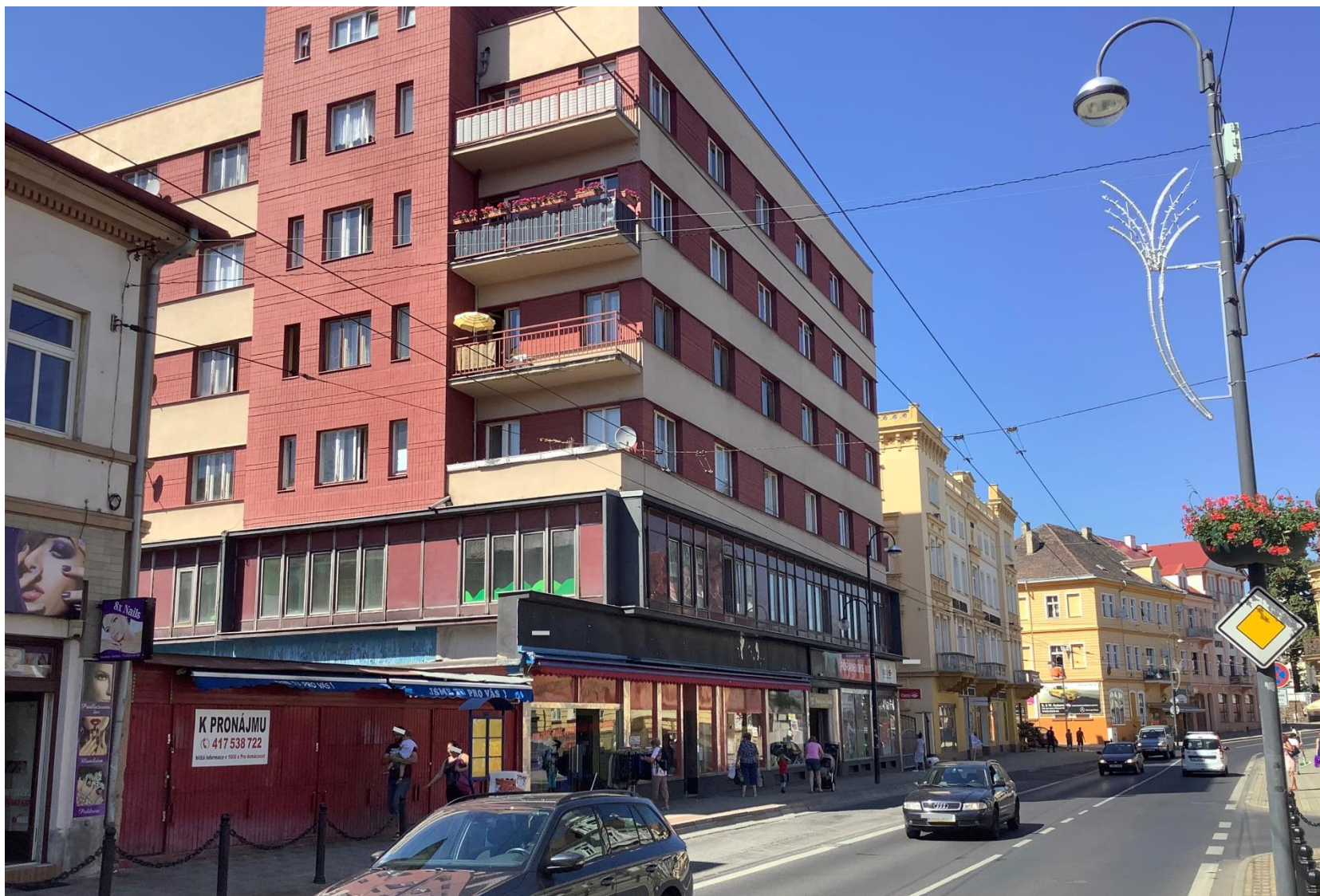
Obr. 13: Fotodokumentace zástavby v okolí kritického místa č. 3 priority I na Masarykově třídě v Teplicích
