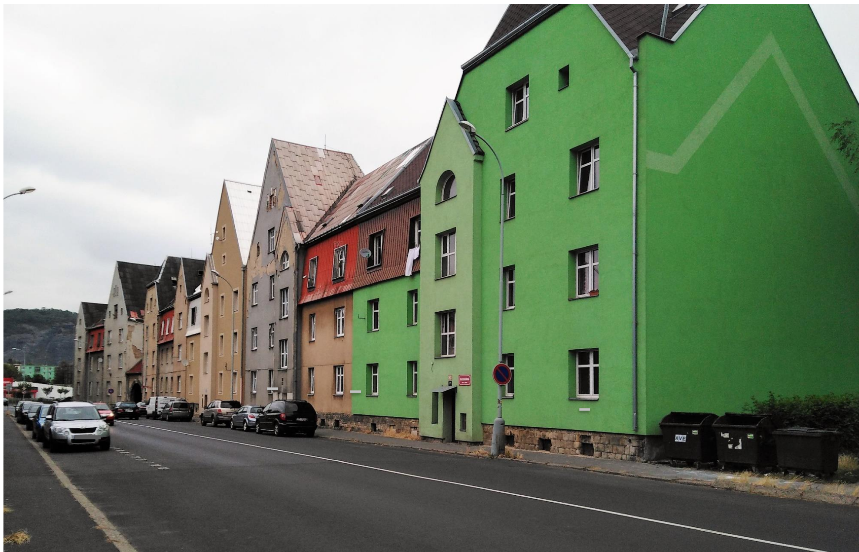
Obr. 22: Fotodokumentace zástavby v okolí kritického místa č. 8 priority I v ulici Železničářská v Ústí nad Labem
