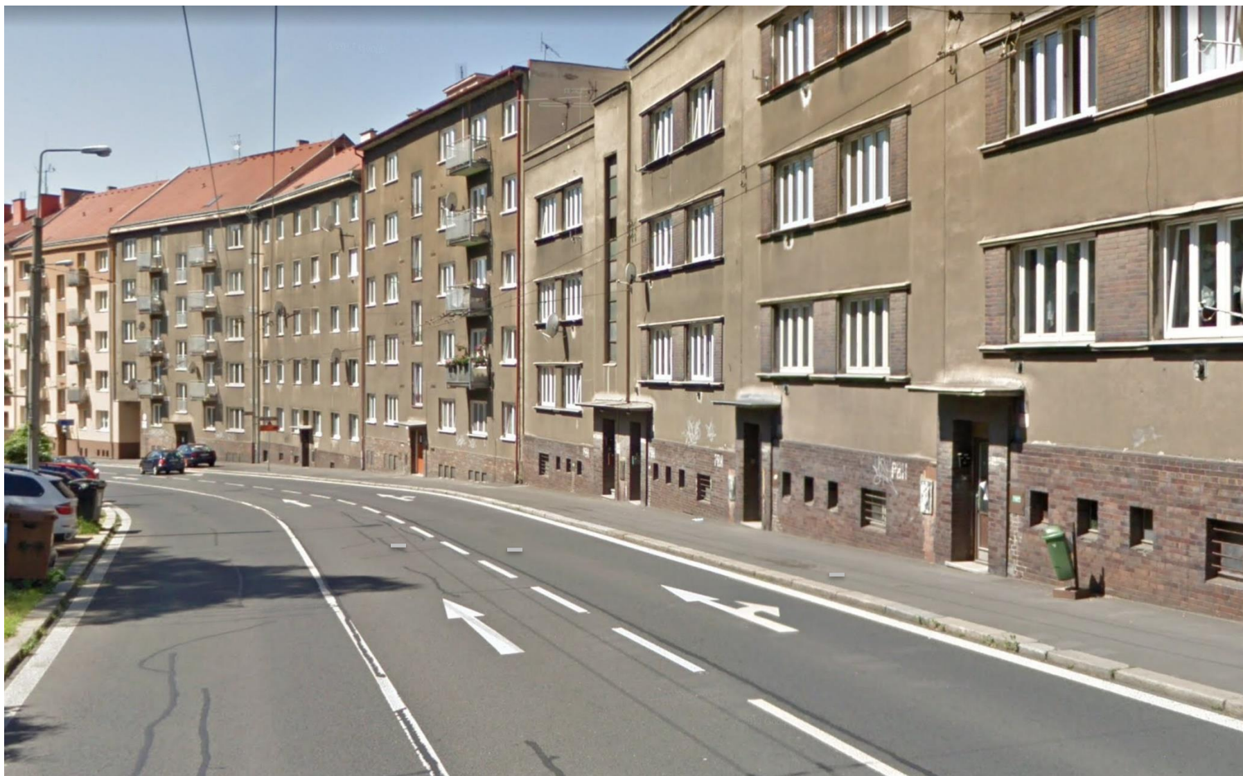
Obr. 19: Fotodokumentace zástavby v okolí kritického místa č. 6 priority I v ulici Důlce (I/30) v Ústí nad Labem
