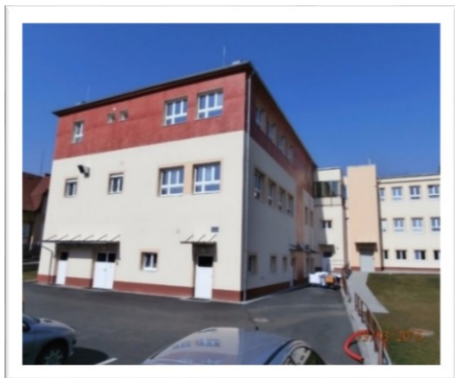
Pohled na přístavbu z jižní strany
