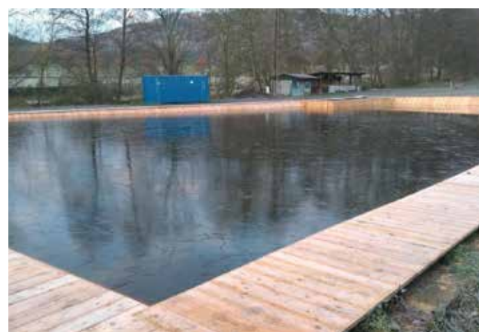
TAKTO VYPADÁ dnes požární nádrž v Chudoslavicích.
