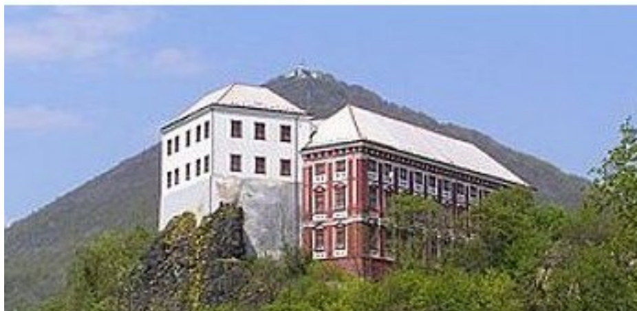
Obrázek 6 Domov důchodců Milešov
