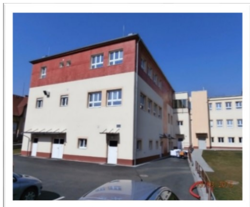
Pohled na přístavbu z jižní strany
