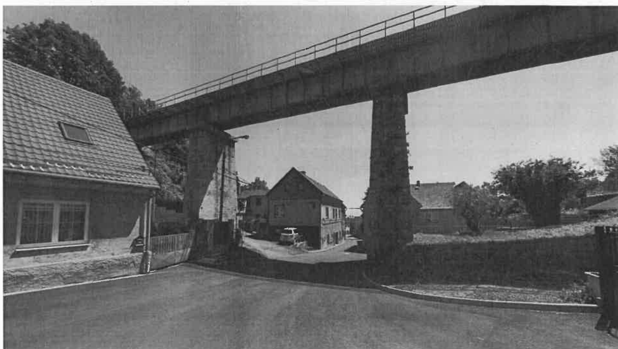
Obr. 4 – Železniční most v obci Hrob v bezprostřední blízkosti bytových domů
